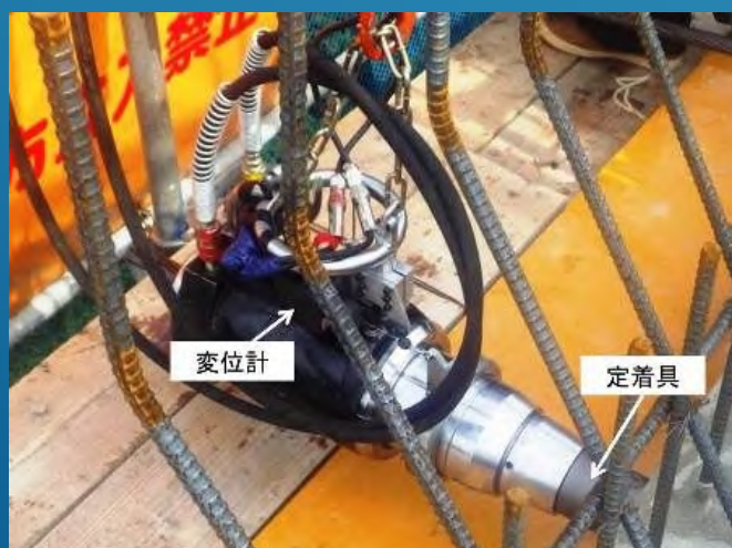
緊張状況ジャッキ及び伸び計
